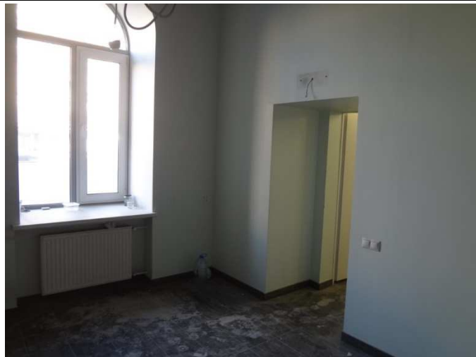
Фото 6. Состояние помещения стоматологии
