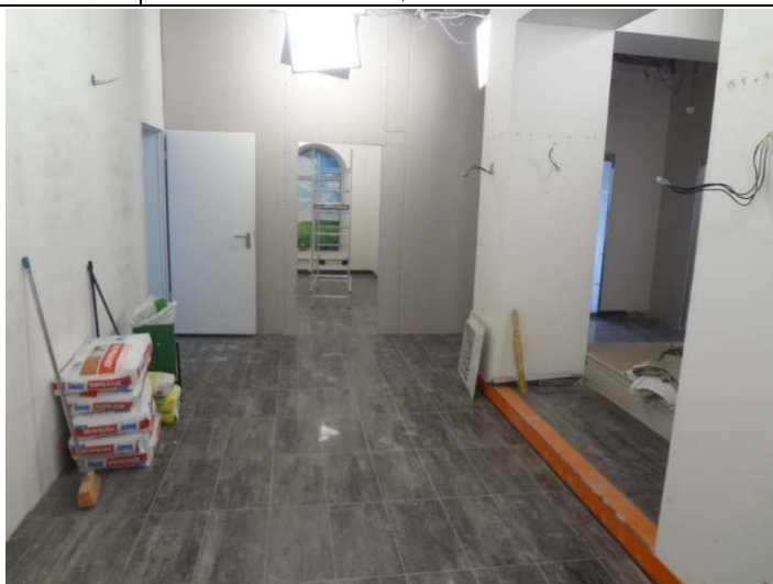
Фото 9. Состояние помещения стоматологии
