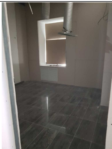
Фото 7. Состояние помещения стоматологии
