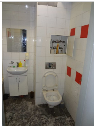
Фото 10. Состояние помещения стоматологии
