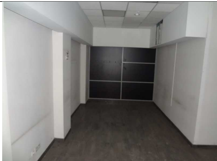
Фото 8. Состояние помещения стоматологии
